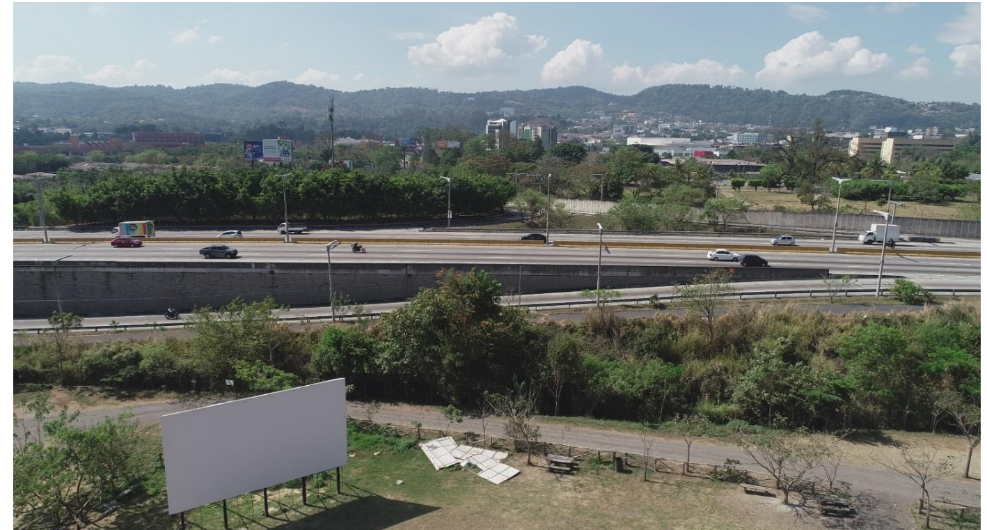
Figura 12. Vista dron Bulevar Monseñor Romero, marzo 2021. Fuente: visita de campo MARN 2021
